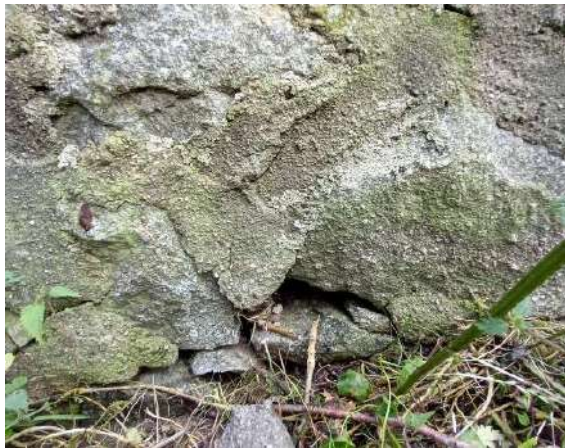
Figure 181 : petite lacune dans la maçonnerie en pied de mur
