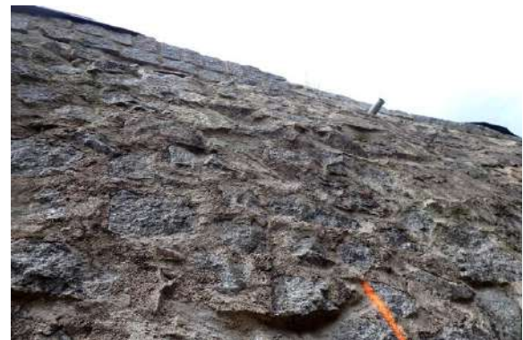
Figure 72 : bombement près de la cote 16m
