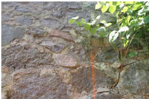
Figure 110 : ouverture dans les joints de la maçonnerie
