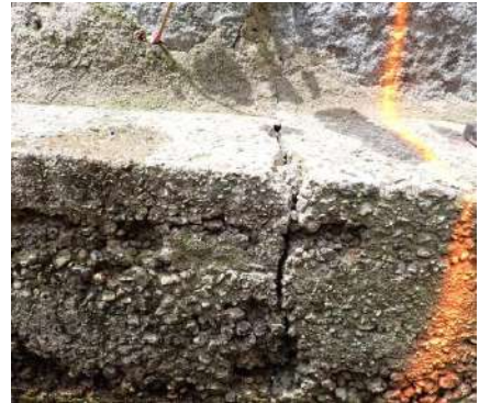
Figure 76 : fracture transversale de 1,5 cm sur la longrine
