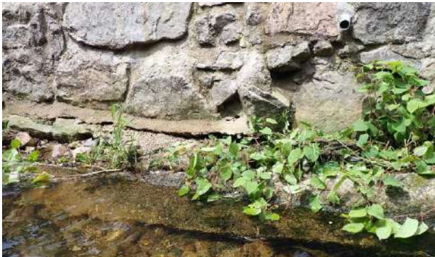
Figure 34 : végétation entre le mur et la longrine béton
