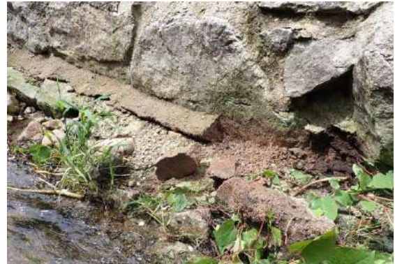
Figure 35 : dislocation du mortier de rejointoiement
