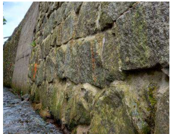
Figure 172 : léger bombement au pied du mur
