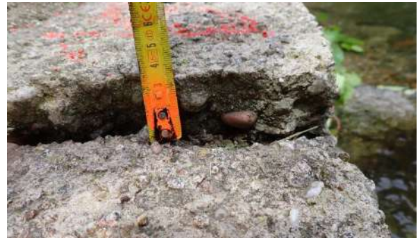
Figure 70 : désaffleurement de 4 cm de la longrine
