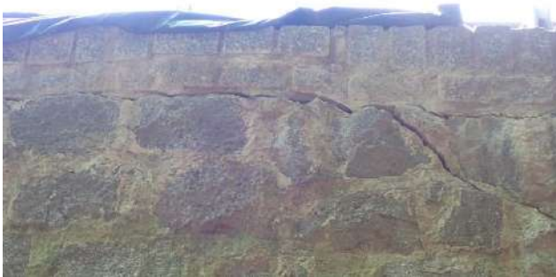
Figure 134 : fissure au niveau du couronnement
