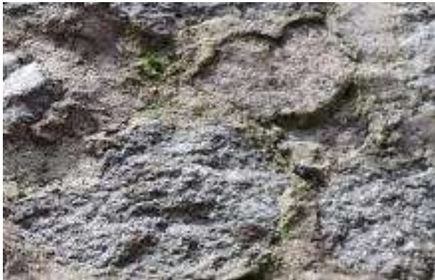
Figure 53 : présence de mousse dans les joints
