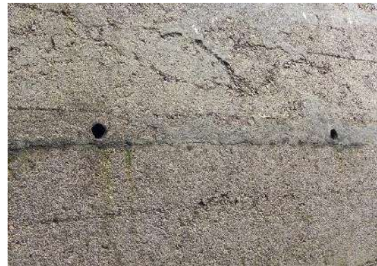
Figure 164 : des traces d'humidité et de mousse au droit des barbacanes
