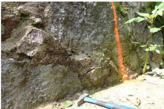
Figure 103 : bombement en partie basse du mur
