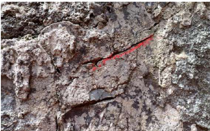
Figure 77 : léger bombement à mi-hauteur du mur
