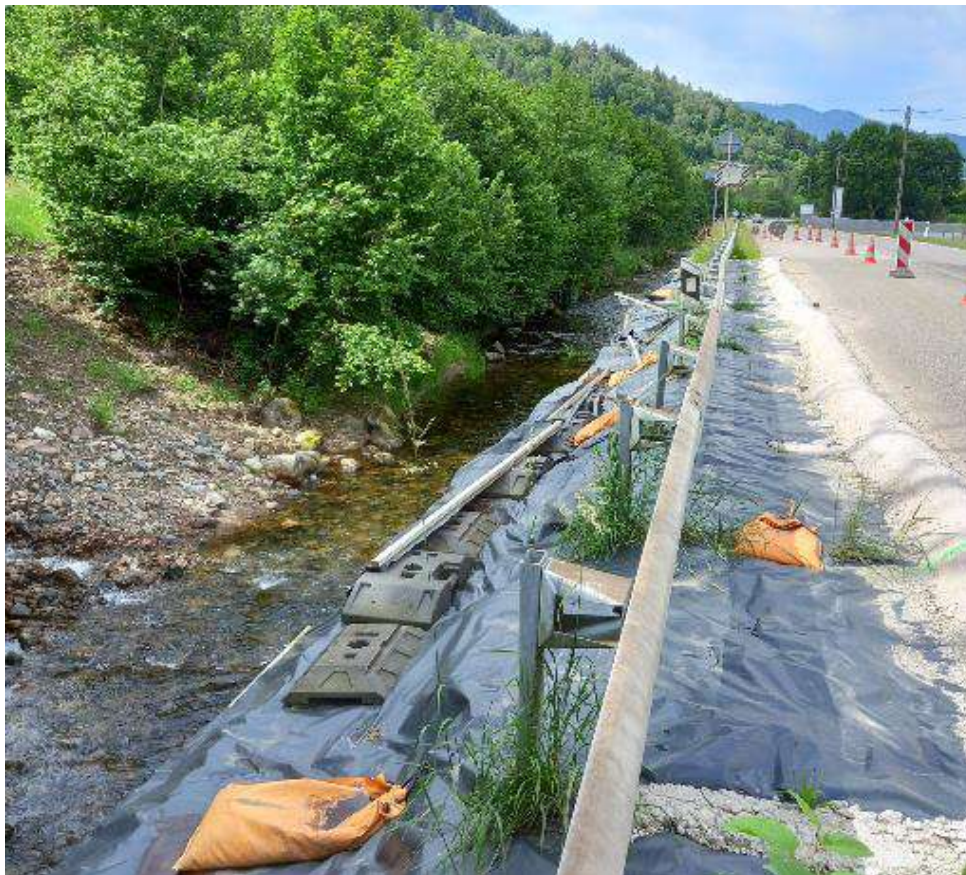
Figure 8 : bâche et bordure temporaire en béton, vue depuis l'amont
