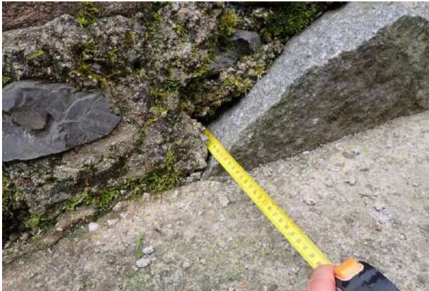
Figure 65 : petite lacune dans la maçonnerie
