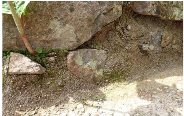
Figure 92 : des traces de mousse dans les joints
