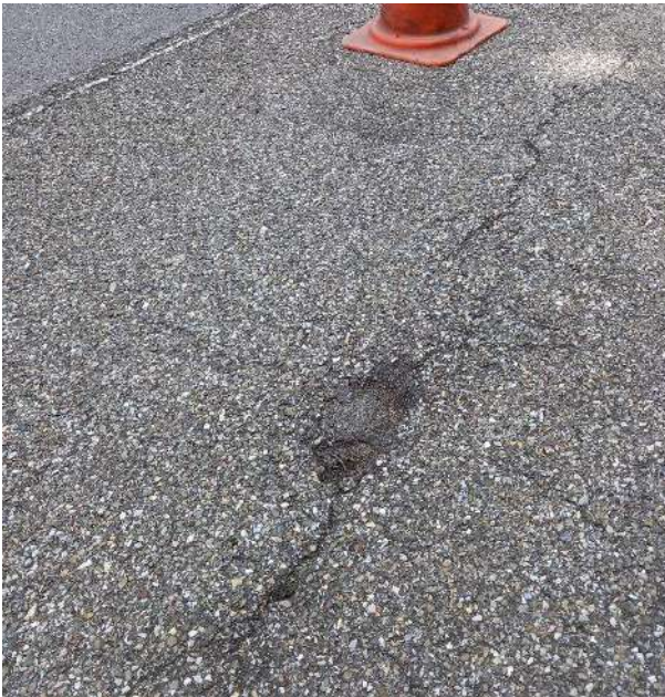
Figure 14 : arrachement localisé de l'enrobé
