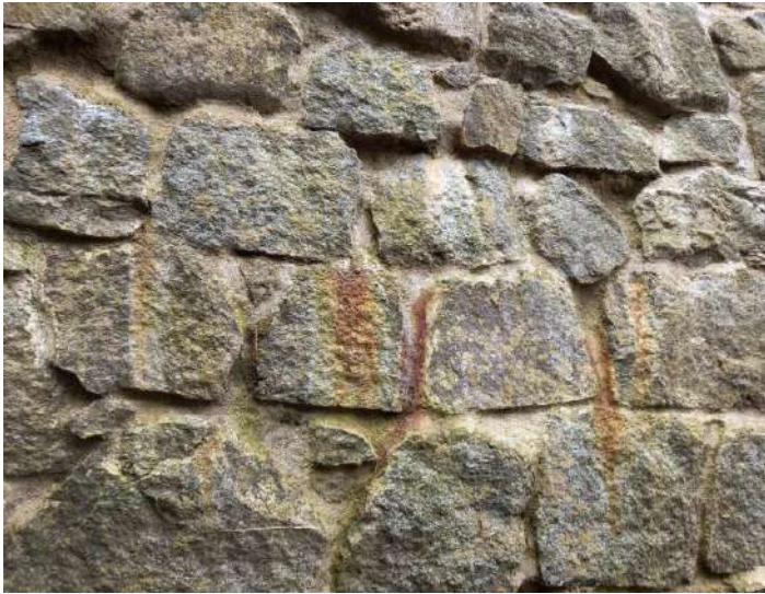
Figure 167 : des traces de ruissellement dans les joints et sur les pierres
