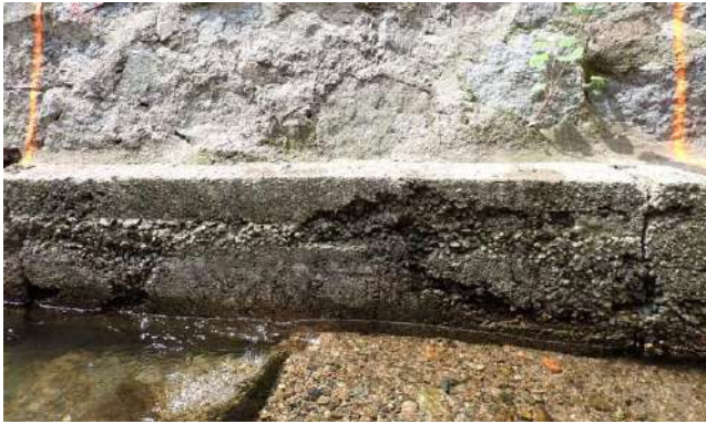
Figure 75 : vue générale de la longrine : nids de cailloux avec lacunes et affouillement
