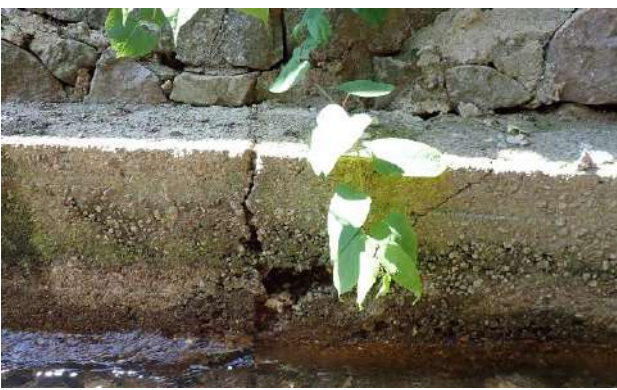
Figure 115 : fractures et lacune sur la longrine
