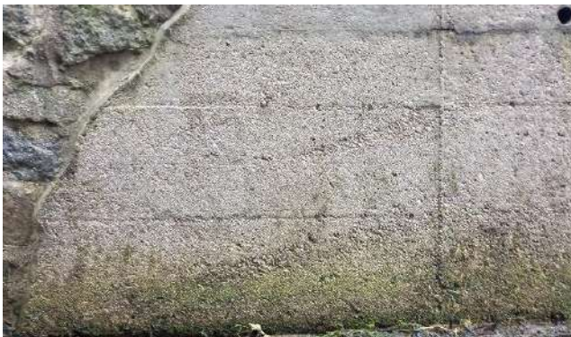
Figure 163 : nids de cailloux en partie basse de l'ancien « voile » de réparation en béton
