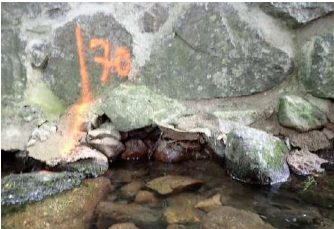
Figure 156 : léger affouillement au pied du mur
