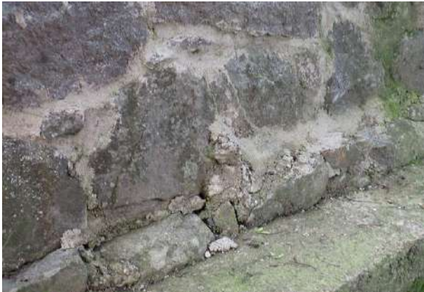
Figure 148 : décollement et effritement du mortier de rejointoiement
