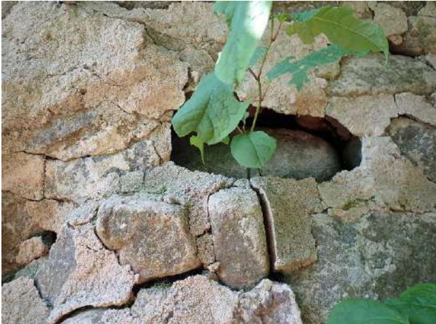
Figure 113 : dislocation du mortier de rejointoiment
