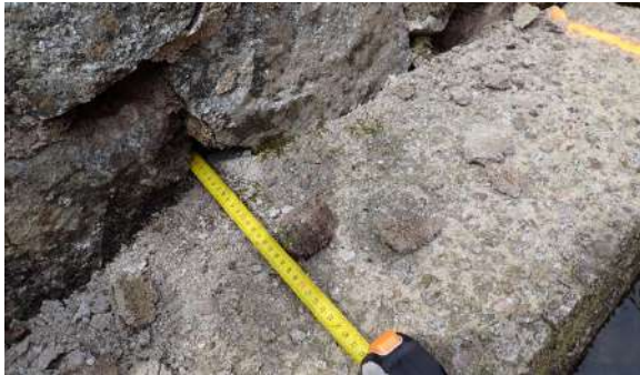
Figure 69 : lacune dans la maçonnerie sur 50 cm de profondeur
