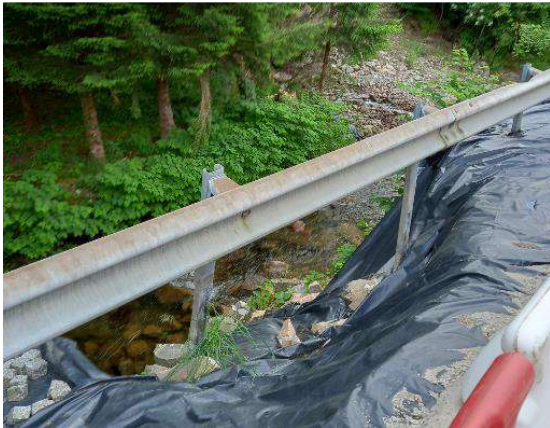
Figure 20 : montants détachés de la glissière dans la zone effondrée
