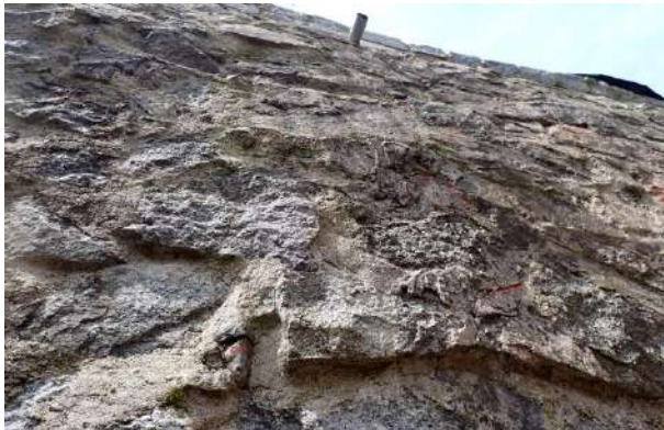
Figure 77 : léger bombement à mi-hauteur du mur
