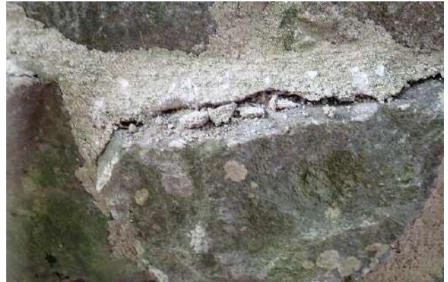
Figure 139 : effritement du mortier de rejointoiment
