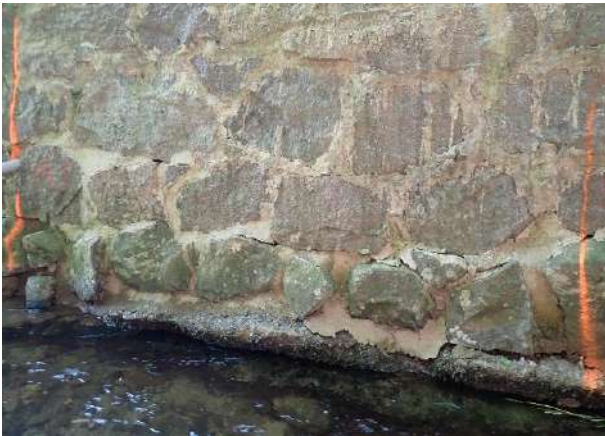
Figure 132 : décollement du mortier
