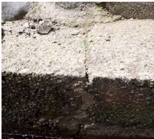
Figure 85 : reprise de bétonnage, nids de cailloux et granulats apparents sur longrine
