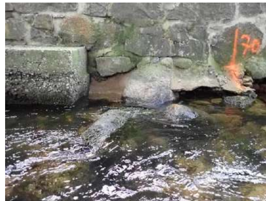
Figure 153 : affouillement généralisé au pied du mur
