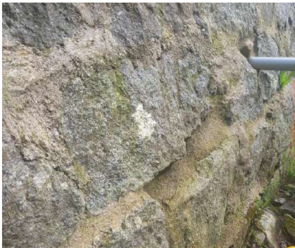
Figure 176 : léger bombement en pied de mur
