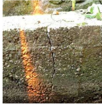
Figure 107 : fracture verticale sur la longrine
