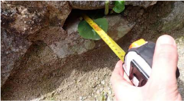
Figure 91 : lacune profonde dans la maçonnerie au pied du mur
