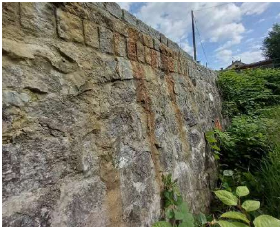
Figure 187 : des traces de ruissellement sur le parement du mur
