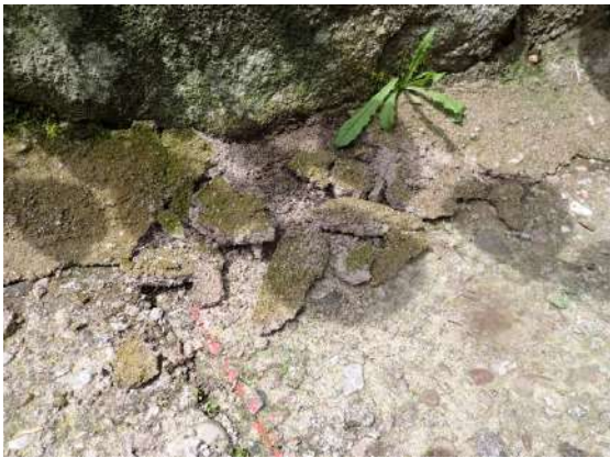
Figure 59 : effritement du mortier de rejointoiement
