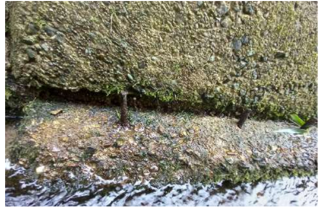
Figure 162 : fers apparents sur la longrine situés au pied de mur
