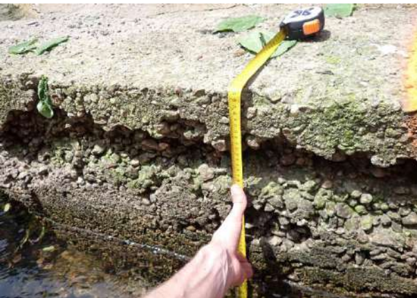
Figure 41 : longrine d'une hauteur de 60 cm
