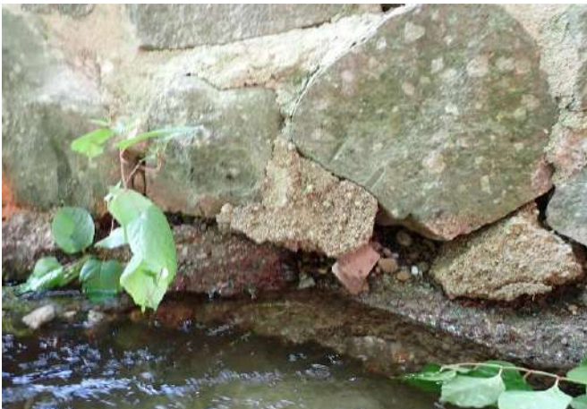
Figure 140 : décollement du mortier de rejointoiment et lacune dans la maçonnerie
