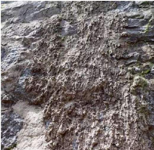
Figure 87 : ravinement du mortier par la pluie avant sa prise
