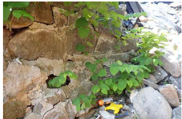
Figure 116 : déformation vers l'avant du parement
