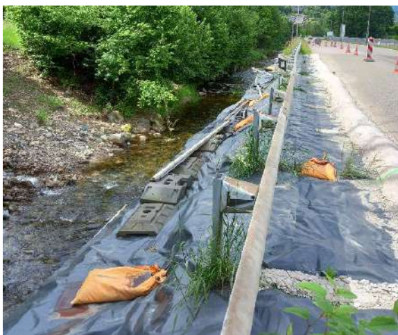
Figure 18 : défaut d'alignement de la glissière de sécurité
