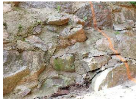
Figure 111 : bombement en partie basse du mur
