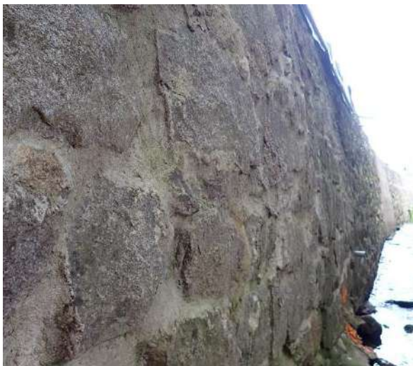
Figure 154 : bombement sur toute la hauteur
