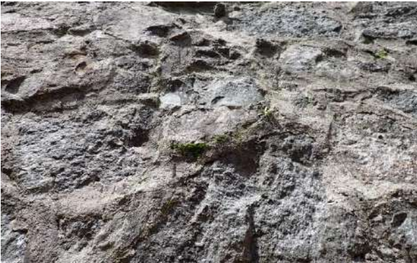
Figure 39 : mousse dans les joints
