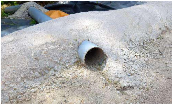
Figure 22 : vue générale de la descente d'eau temporaire
