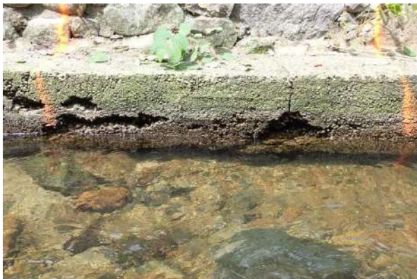
Figure 49 : reprise de bétonnage sur longrine
