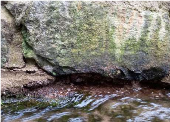
Figure 169 : affouillement en pied de mur
