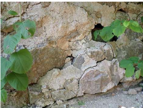
Figure 117 : lacune au niveau du joint
