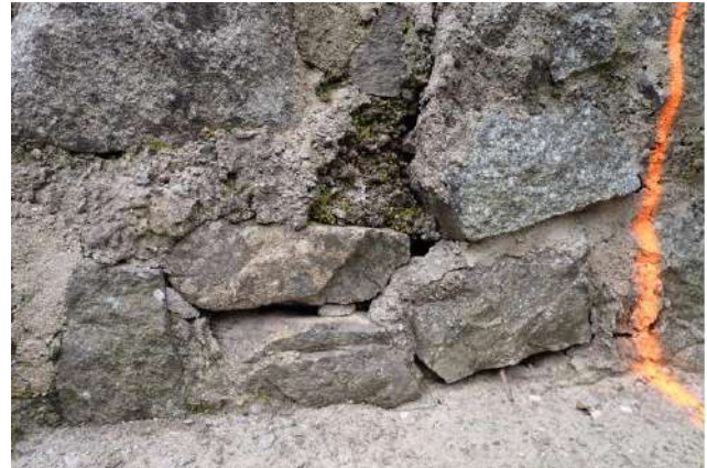
Figure 66 : vue générale du disjointement
