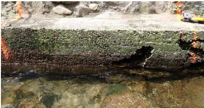
Figure 53 : présence de mousse dans les joints
