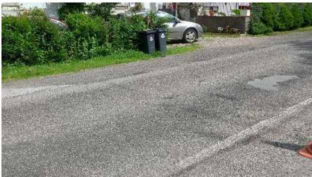
Figure 12 : plusieurs fissures transversales et des zones d'arrachement de l'enrobé réparées
