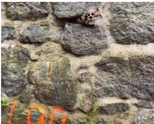
Figure 171 : présence d'ancienne racine dans le mur
