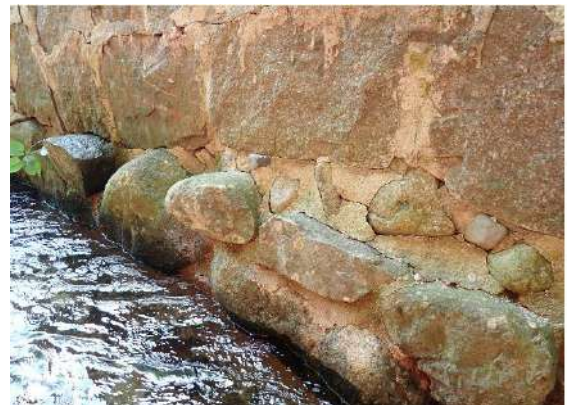
Figure 129 : mouvement de pierres en soubassement
