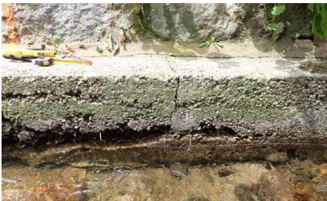
Figure 61 : vue générale de la longrine : lacune, fissure et affouillement
