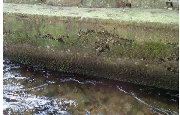
Figure 145 : affouillement généralisé sous la longrine
