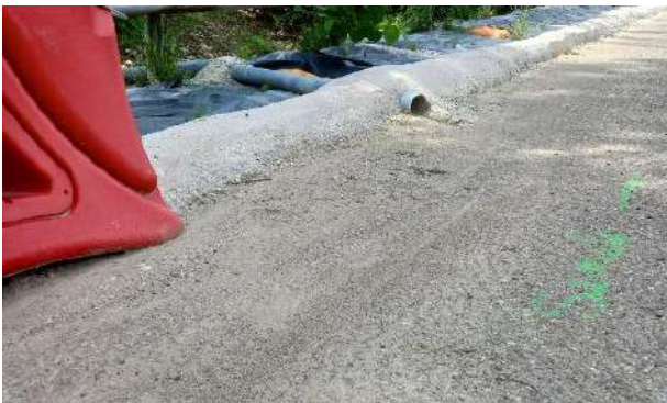
Figure 16 : dépôt de sable en rive de chaussée
