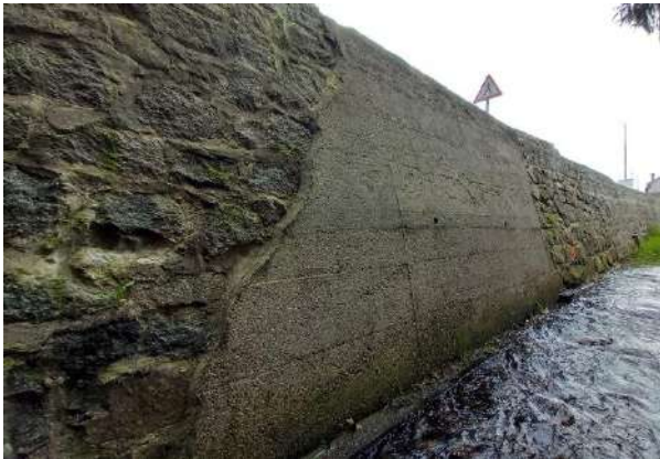
Figure 159 : ancien « voile » de réparation en béton
