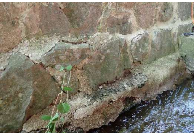
Figure 142 : affouillement sur toute la largeur de la section
