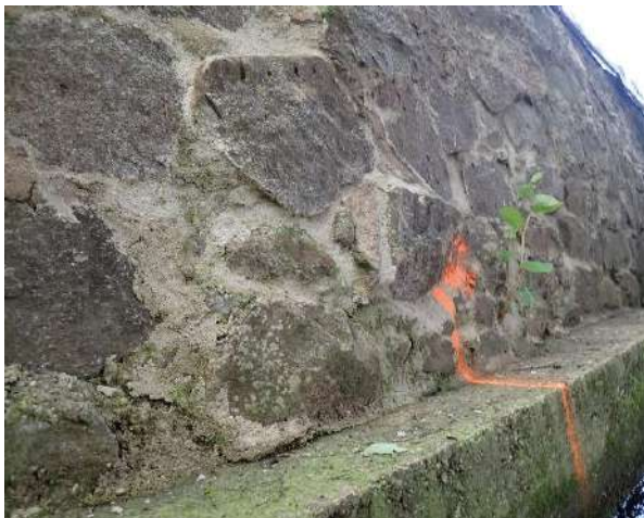
Figure 150 : bombement en partie basse
