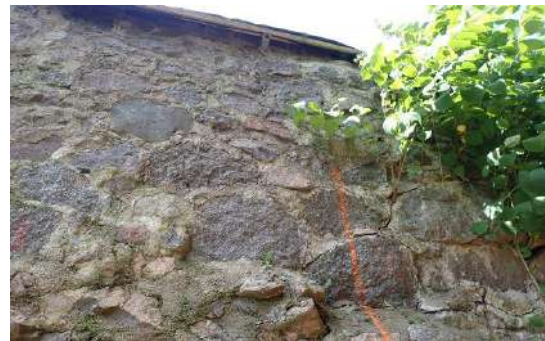
Figure 109 : mouvement en partie haute du mur
