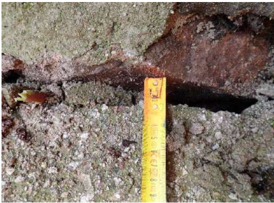
Figure 108 : ouverture entre la longrine et le mur
