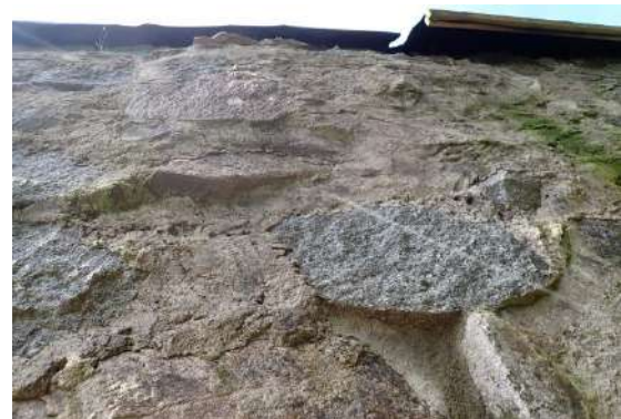
Figure 104 : bombement en partie haute
