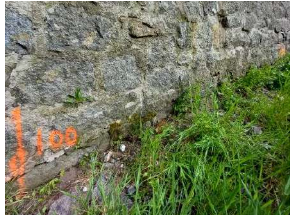
Figure 180 : des dépôts de sable, de sédiments et de végétation
