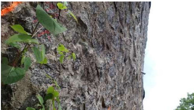
Figure 71 : léger bombement à mi-hauteur du mur
