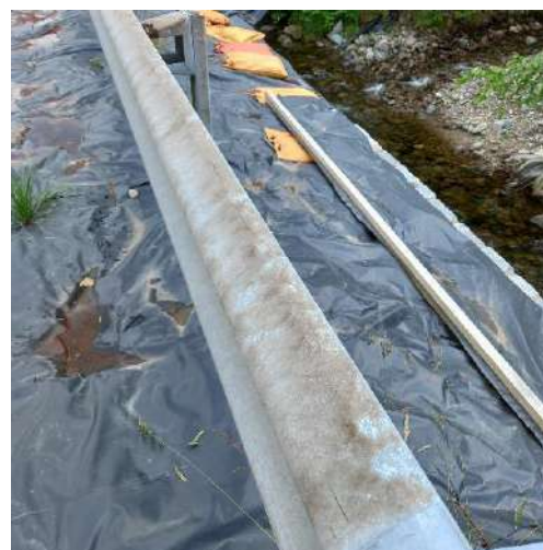
Figure 19 : de légères traces d'oxydation sur la glissière de sécurité
