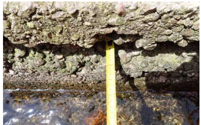
Figure 42 : lacune et nids de cailloux sur longrine en béton
