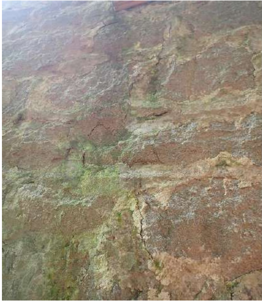
Figure 138 : fissuration du mortier de rejointoiment
