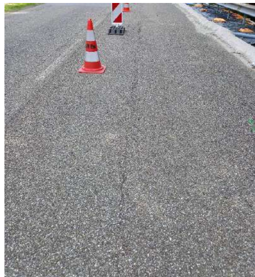
Figure 13 : fissure longitudinale de l'enrobé sur la chaussée dir. Bussang
