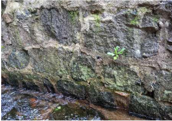
Figure 161 : effritement du mortier de rejointoiement en partie basse du mur
