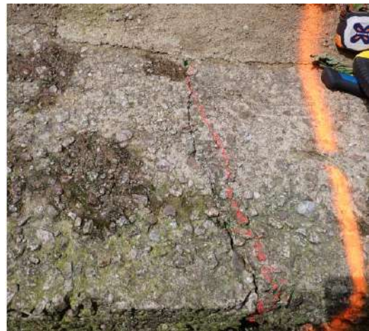
Figure 56 : fissure transversale sur le béton de la longrine
