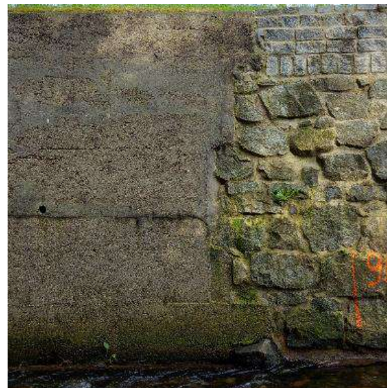
Figure 166 : vue de la partie du mur après l'ancien « voile » de réparation en béton
