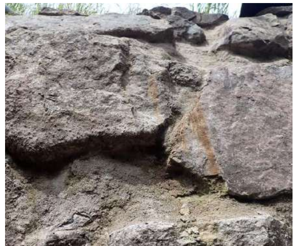
Figure 37 : des traces d'humidité sur les pierres et dans les joints
