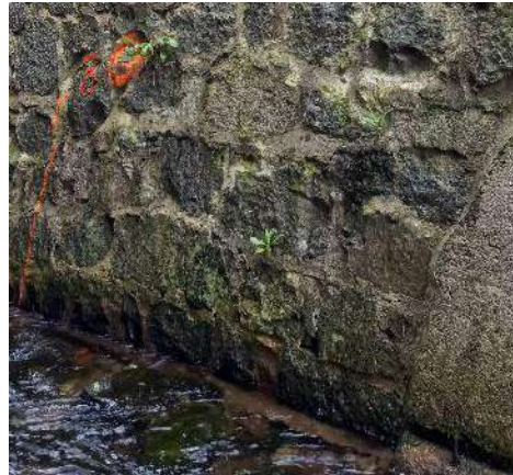
Figure 160 : léger affouillement en partie aval de l'ancien « voile » de réparation en béton
