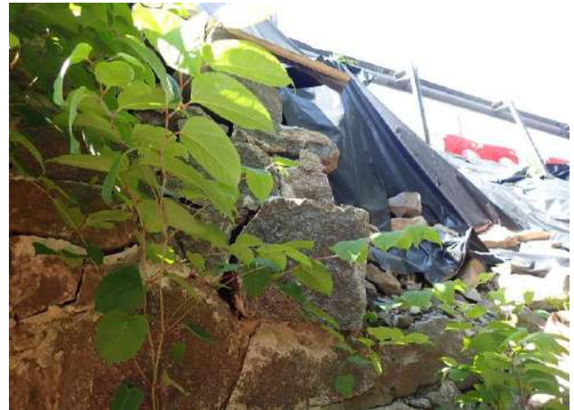
Figure 114 : pierres proches de l'effondrement
