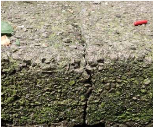
Figure 49 : reprise de bétonnage sur longrine
