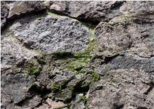
Figure 45 : mortier humide avec la présence de mousse
