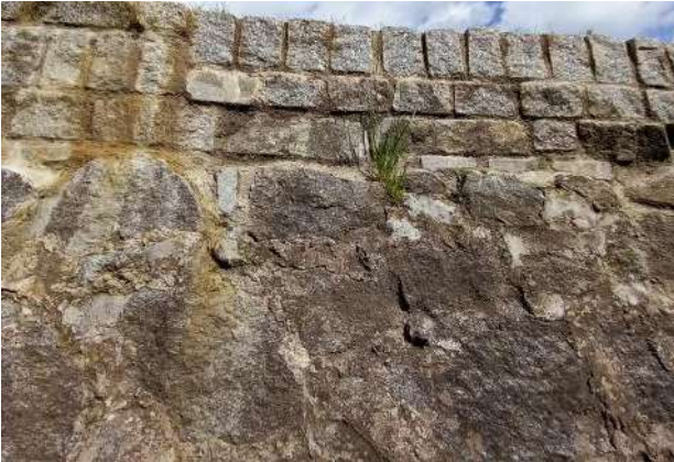
Figure 184 : végétation dans les joints en partie supérieure du mur
