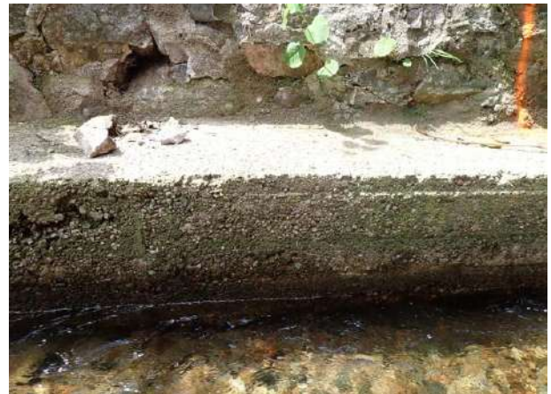
Figure 98 : des nids de cailloux et affouillement sous la longrine
