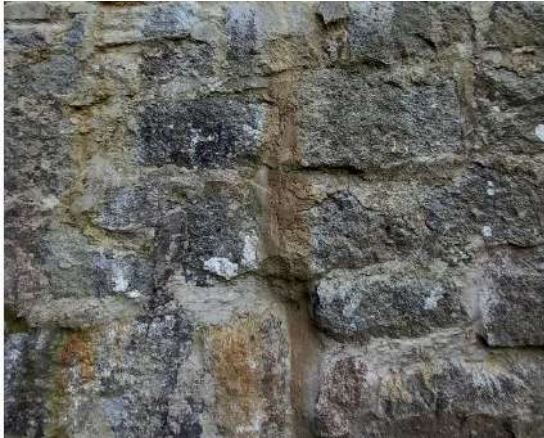
Figure 179 : des traces de ruissellement dans les joints et sur les pierres
