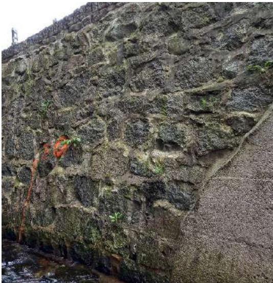
Figure 165 : vue du mur en aval de l'ancien « voile » de réparation en béton
