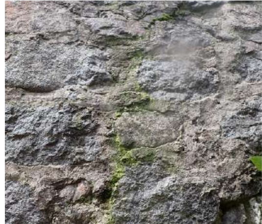
Figure 60 : traces de mousse dans les joints
