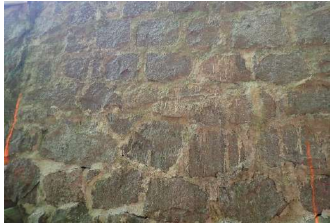
Figure 133 : lessivage du mortier de rejointoiement
