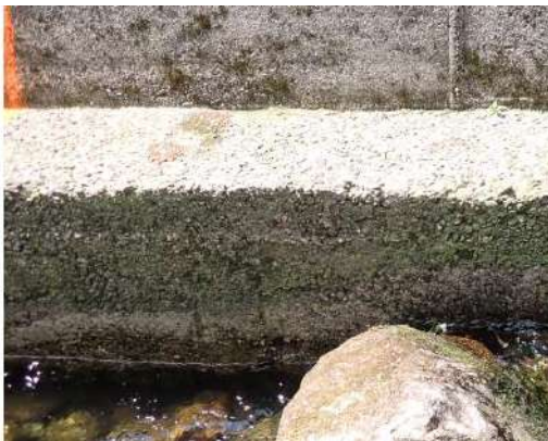
Figure 89 : affouillement sous la longrine en partie aval
