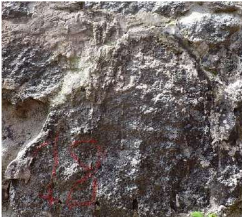
Figure 81 : mortier raviné par l'eau avant sa prise
