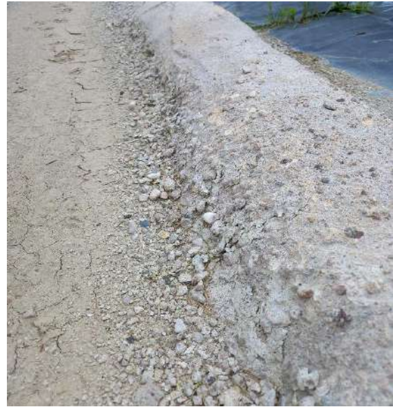
Figure 15 : effritement du béton sur la bordure temporaire en béton destinée à contenir l'eau
