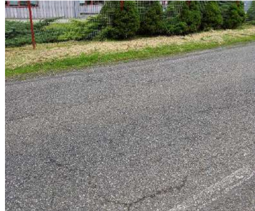
Figure 11 : faïençage généralisé chaussée dir. Saint-Maurice-sur-Moselle
