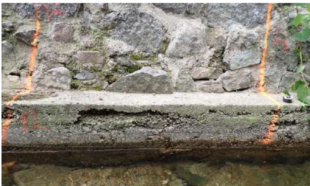
Figure 67 : vue générale de la longrine : lacune, nids de cailloux et affouillement
