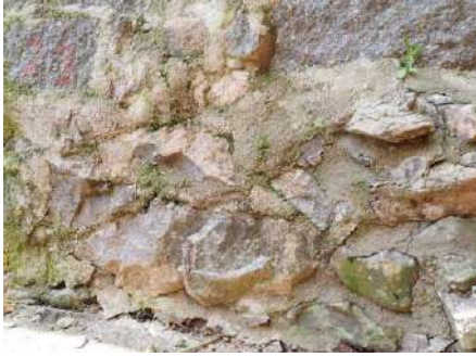
Figure 106 : traces de mousse et humidité au niveau du mortier de rejointoiment
