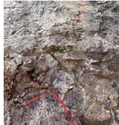
Figure 78 : pierres fracturées en partie haute
