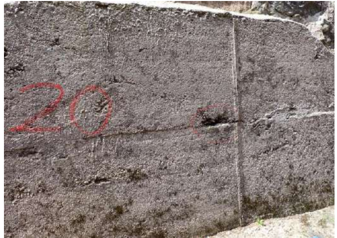
Figure 88 : ancien renforcement en béton avec présence de nids de cailloux
