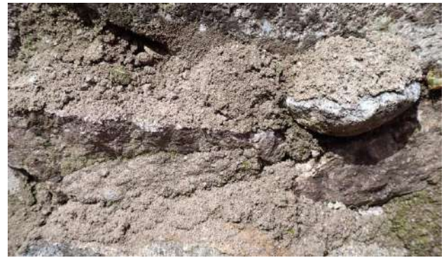
Figure 40 : effritement du mortier de rejointoiment
