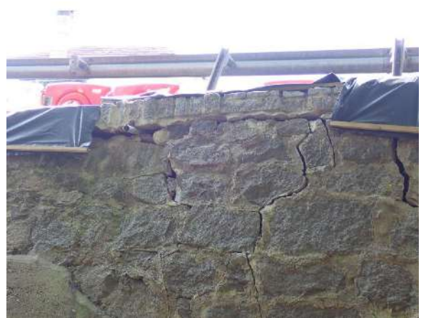
Figure 131 : fractures en partie haute
