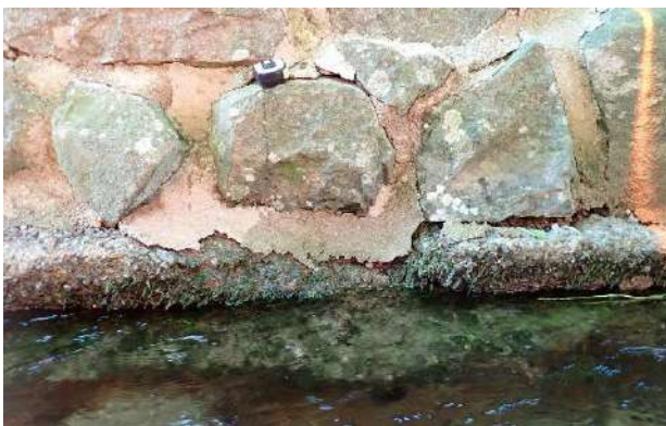
Figure 136 : affouillement au pied du mur
