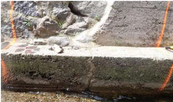
Figure 83 : renforcement en béton au-dessus de la longrine
