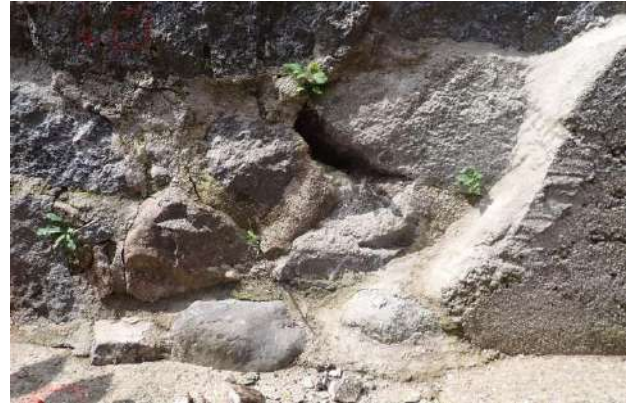
Figure 82 : décollement du mortier de rejointoiement
