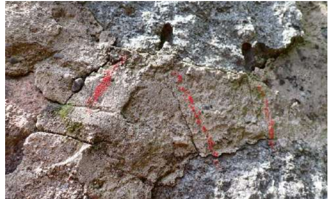
Figure 96 : fissuration du mortier de rejointoiement
