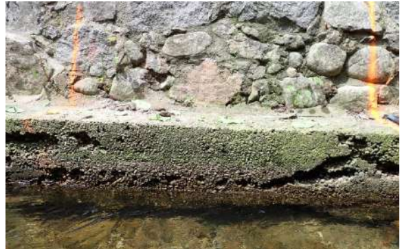
Figure 46 : vue générale de la longrine en béton : lacunes, nids de cailloux et affouillement
