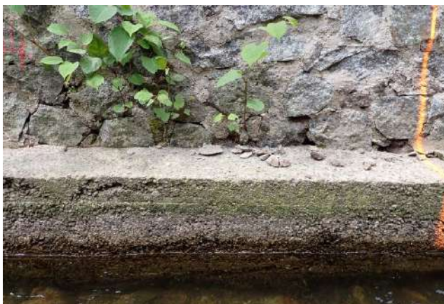
Figure 71 : léger bombement à mi-hauteur du mur
