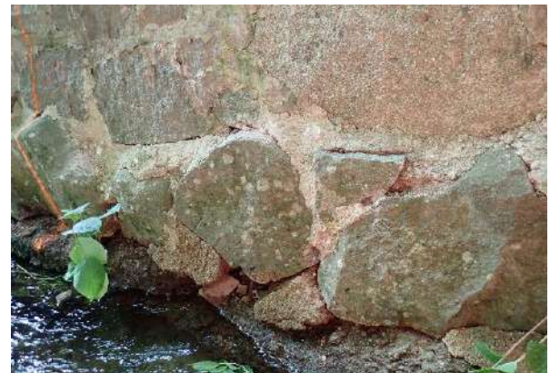
Figure 141 : mouvement de la maçonnerie en soubassement
