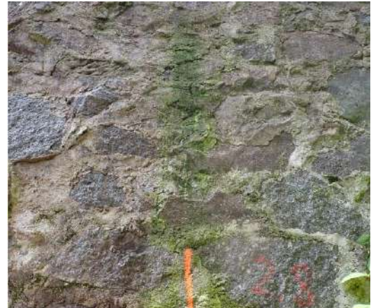
Figure 102 : traces de mousse dans les joints
