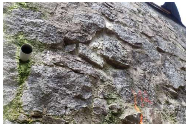
Figure 62 : léger bombement à mi-hauteur
