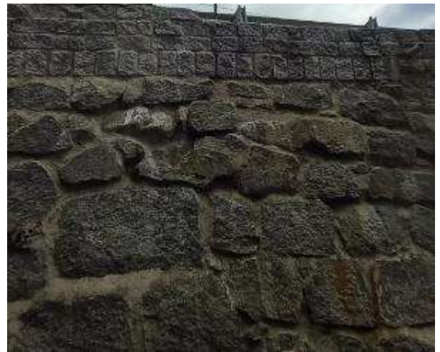
Figure 168 : couronnement en pavé et barbacane en partie supérieure
