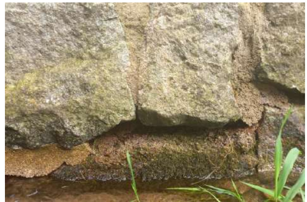
Figure 177 : petite lacune en pied de mur
