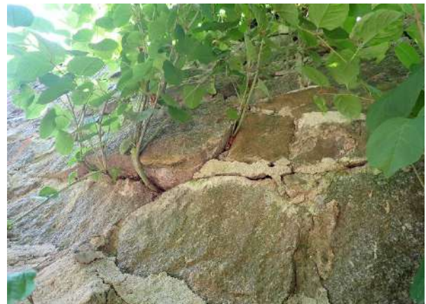
Figure 118 : végétation et bombement en partie haute du mur
