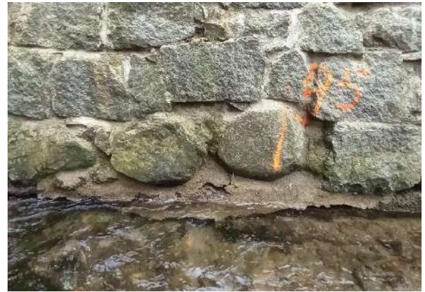
Figure 170 : affouillement en pied de mur à la cote 95 m
