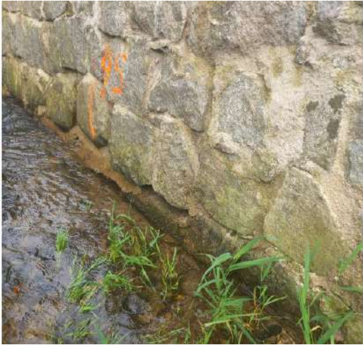
Figure 174 : dépôts de sédiment et végétation au pied du mur
