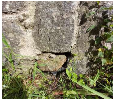
Figure 185 : petite lacune en pied de mur
