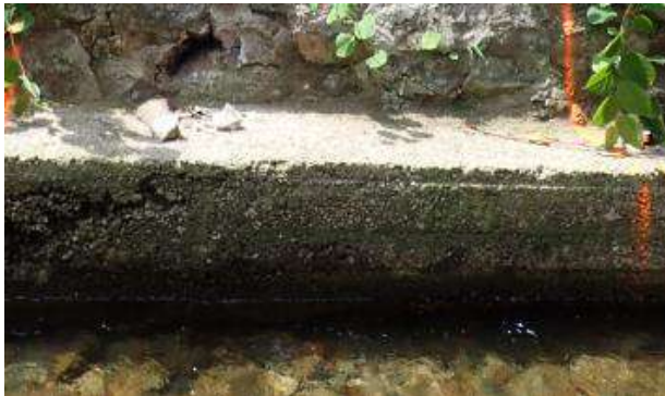
Figure 91 : lacune profonde dans la maçonnerie au pied du mur
