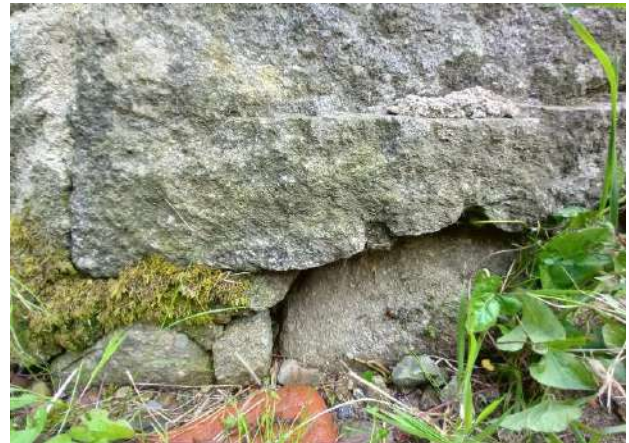
Figure 182 : petite lacune dans la maçonnerie
