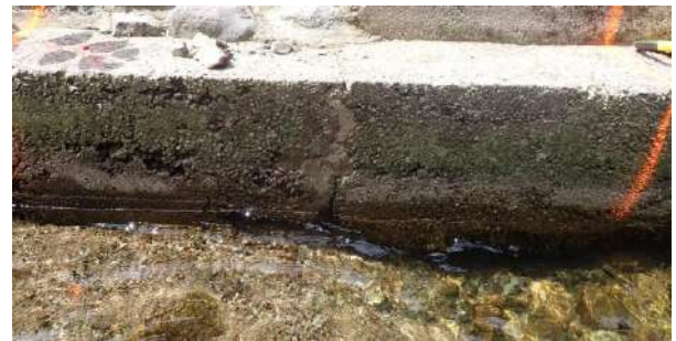
Figure 84 : affouillement sous la longrine
