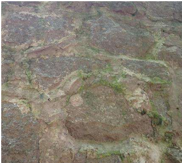
Figure 146 : traces de mousse dans les joints
