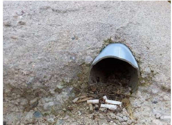
Figure 23 : de légers dépôts au niveau de la descente d'eau temporaire
