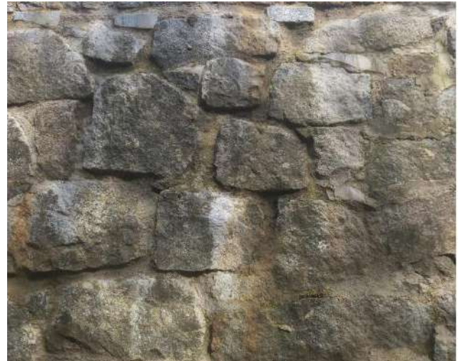
Figure 175 : des traces de ruissellement
