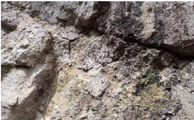
Figure 36 : un effritement du mortier de rejointoiement
